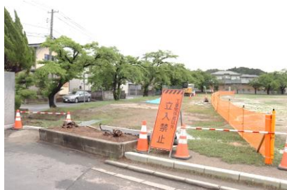
②フェンスを撤去
